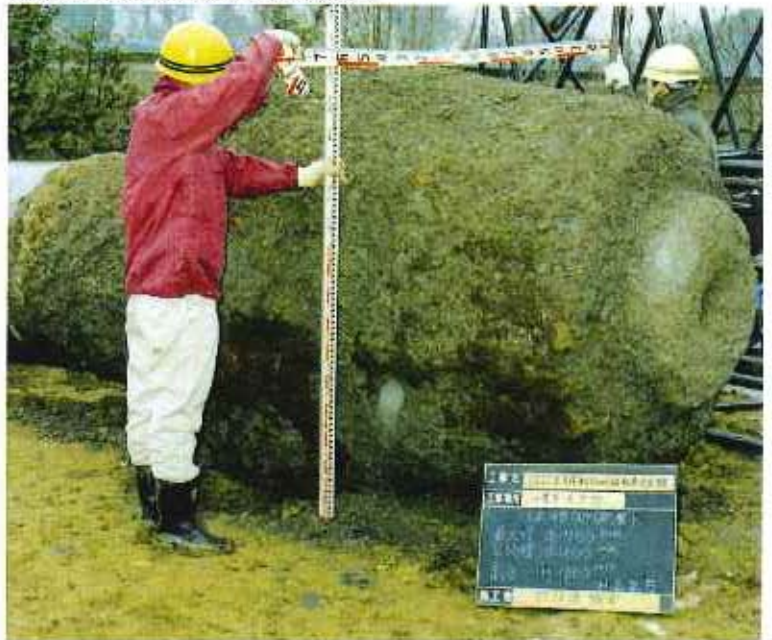
▼杭径1,000mmの球根築造掘出し状況
