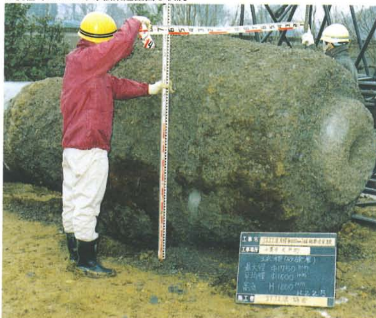
▼杭径1,000mmの球根築造掘出し状況
